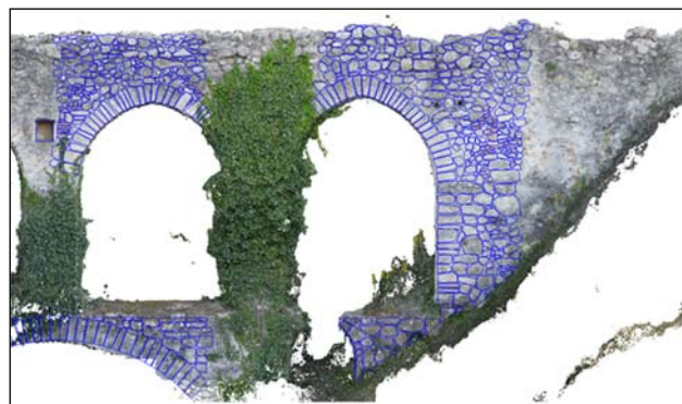
Εικόνα 11 – Απόδοση των λεπτομερειών τοιχοποιίας με τη χρήση προγράμματος CAD [10]
