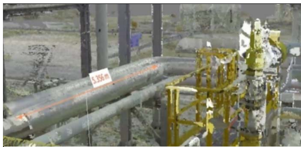
Σχήμα 5 – Μέτρηση απόστασης μεταξύ απρόσιτων σημείων με τη χρήση επαυξημένης πραγματικότητας και του 3D φωτορεαλιστικού μοντέλου
