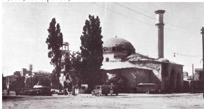
Εικ. 2: Γενική άποψη από ΒΑ πριν την κατεδάφιση
