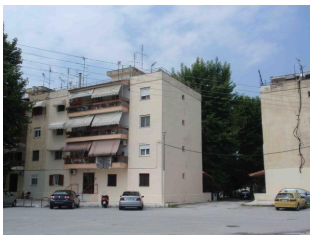
Εικ. 19: Άποψη του συγκροτήματος 4
