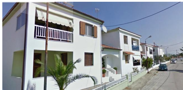
Εικ. 20: Άποψη του συγκροτήματος 5
