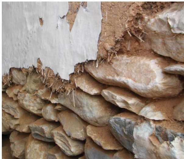
Εικόνα 11 – Σοβάτισμα πέτρινης επιφάνειας με αργιλόχωμα ενισχυμένο με άχυρα. Χρυσό, μέσα 19 ου αι.
