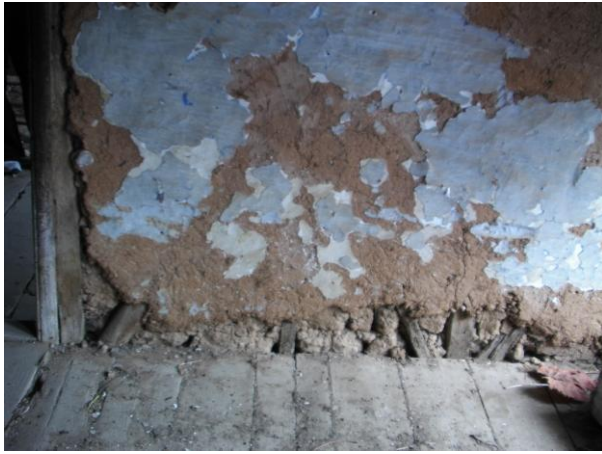
Εικόνα 7 – Διαχωριστικός τοίχος από Τσατμά με ωμές πλίνθες. Έμ. Παπάς, Τέλος 18 ου αι.
