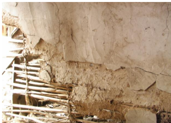
Εικόνα 12 – Η τελευταία στρώση του σοβά στους τσατμάδες γίνονταν με άμμο, πολύ ασβέστη και νερό. Ανώ Πορσία, τέλος 18 ου αι.
