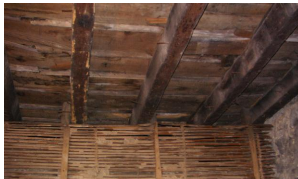
Εικόνα 6 – Εσωτερικός διαχωριστικός τοίχος τσατμάς με καλάμια. Αγ. Πνεύμα, τέλος 18 ου αι.
