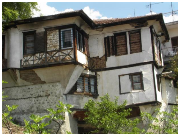
Εικόνα 3 – Διάφοροι τρόποι πλήρωσης σκελετού, σε διαδοχικές επισκευές σε παλιό σπίτι, των Ανω Ποροίων
