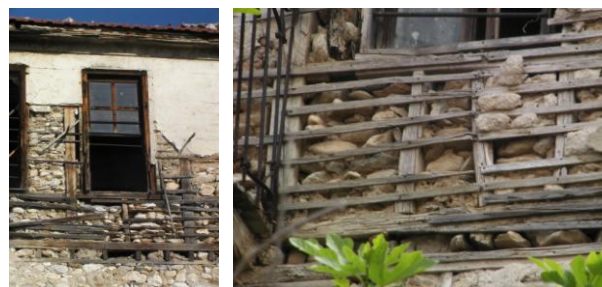
Εικόνα 2 – Πλήρωση σκελετού με παραλλαγή της τεχνικής του τσατμά, σε σπίτια του οικισμού Αγ. Πνεύματος
